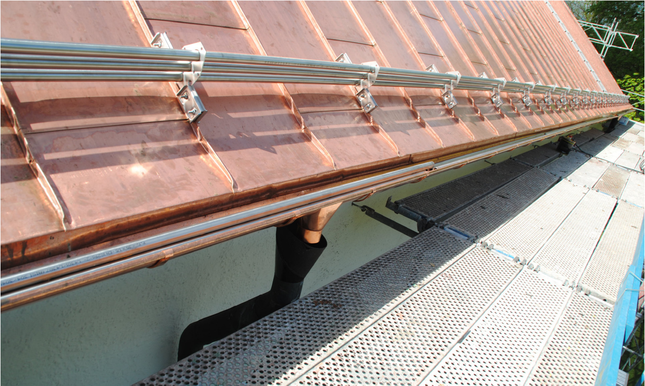
Snörasskydd med rostfria rör och fästen håller på att monteras.
