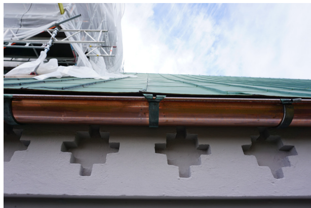
Hyltebruks kyrka, som ligger i samma socken som Färgaryds kyrka, har samma dekorationer på rännkrokarna. Vid byte av hängrännan kunde de befintliga rännkrokarna med dekorationer återanvändas.
