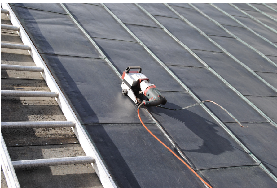
När det gamla koppertaket revs öppnades falsarna med maskin för att underlätta rivningen.
