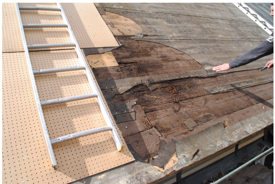
Större rötskada på undertaket nära takfoten på norra sidan av långhustaket.
