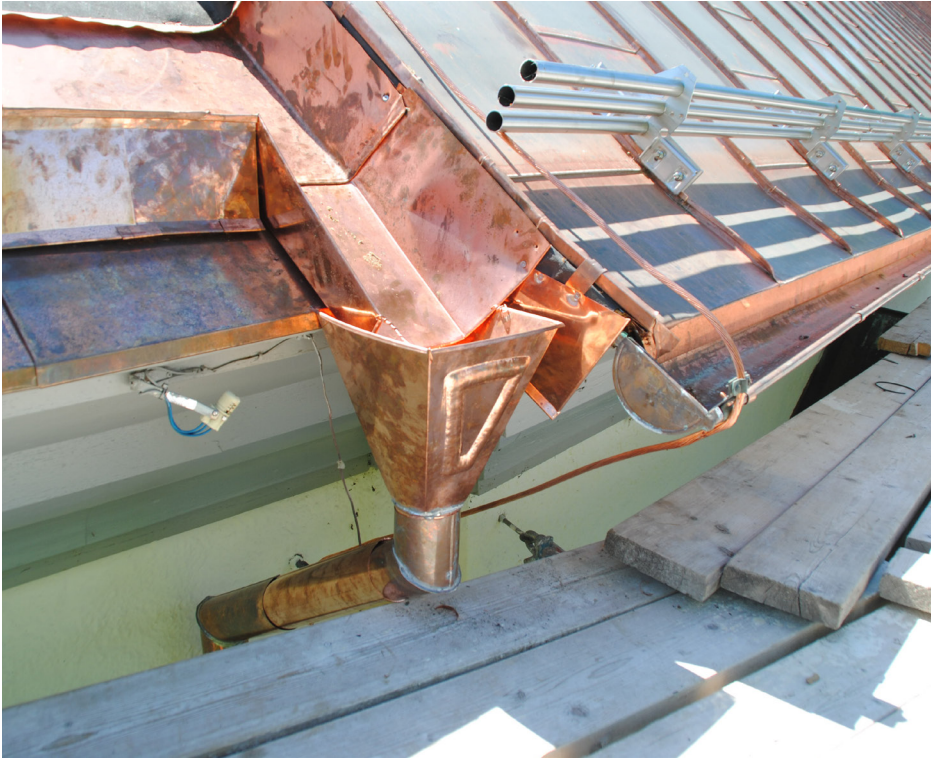
Utkastare och vattenkupa på kortakets norra sida. De nya vattkuporna har fått samma dekor som de gamla hade.
