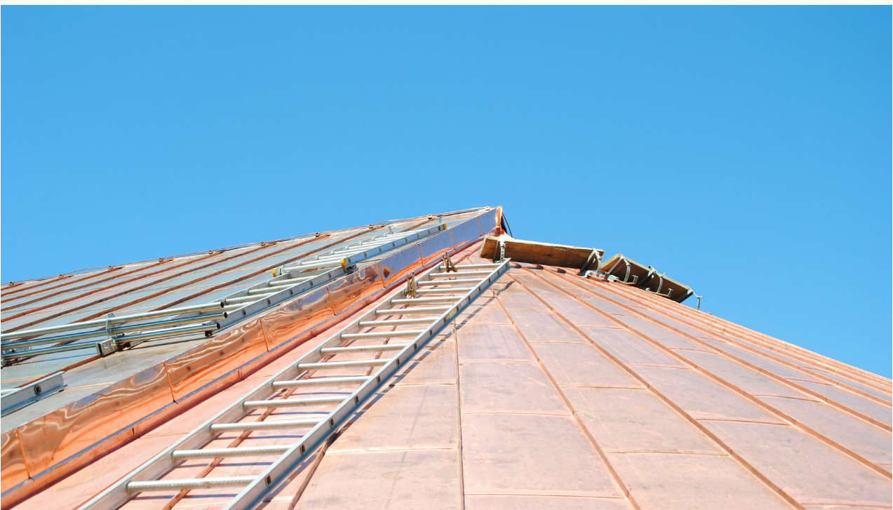
Anslutningen mellan korttak och långhustak håller på att färdigställas.
