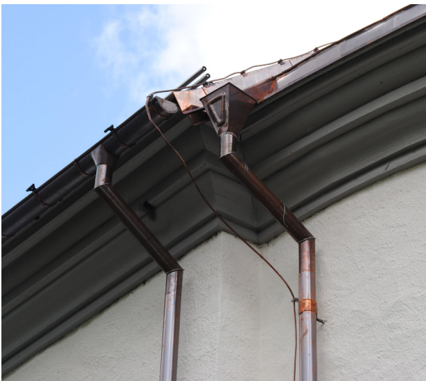
Stuprören har fått skarpa vinklar.
