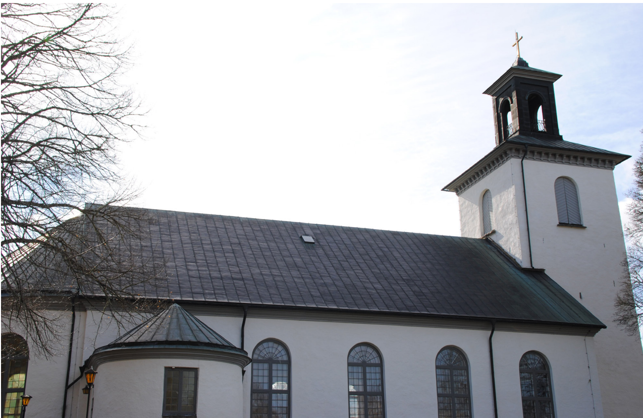
Norra sidan på långhuset före renovering. Ett av takets tre takfönster fanns på denna sida. Skivorna på kopparket hade tvärfalsar förskjutna med en halv skiva.
