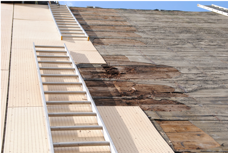
Rötskada mitt på långhustakets norra sida.
