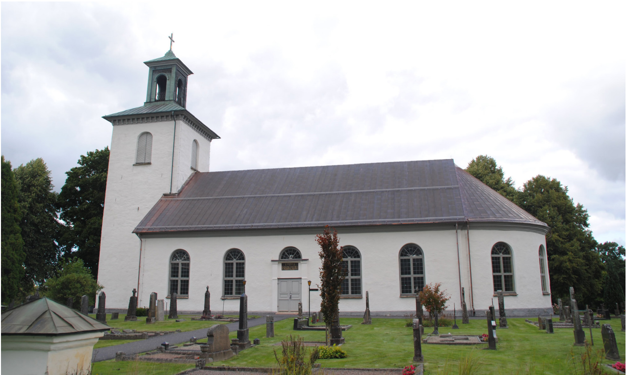
Kyrkan från söder efter omtäckning av koppartaken på långhuset och koret.
