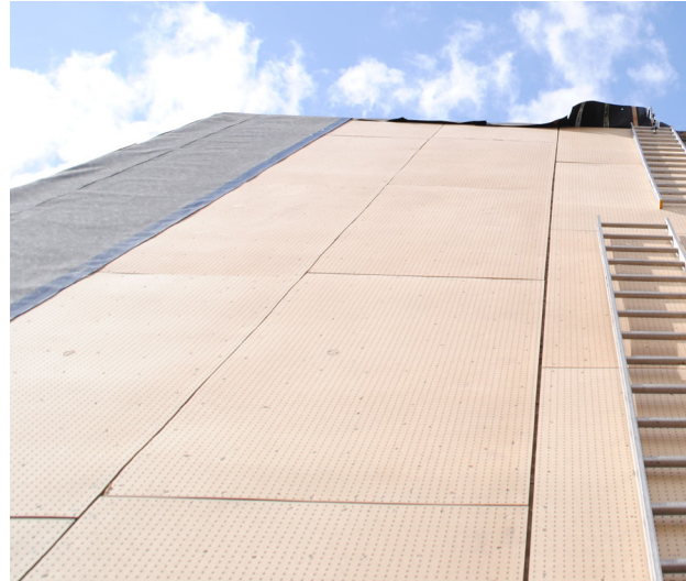
Ovanpå undertaket lades perforerad masonit.
