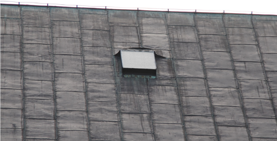
Takfönstret på norra sidan av långhustaket, saknade spröjs.
