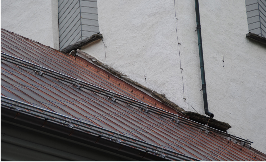
Anslutningen mot tornväggen. Takets ståndskena är uppdragen under den stenkil som finns på tornet.
