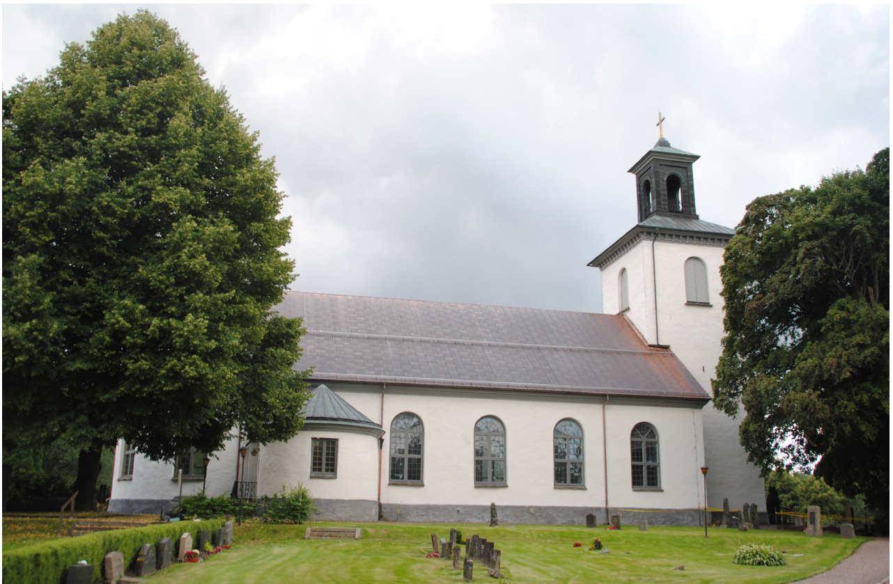
Kyrkan från norr efter omtäckning av långhustaket.
