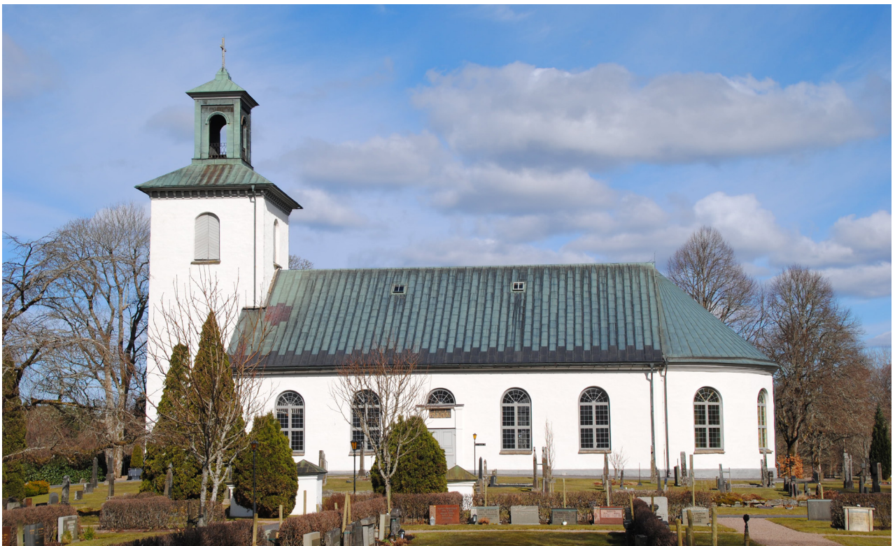
Kyrkan sedd från söder. Pga tidigare läckage hade det tidigare gjorts en ilagning av koppartaket längs med hela takfoten på långhuset.
