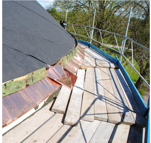
Utkastare till vattenkupan monteras på kortaket.
