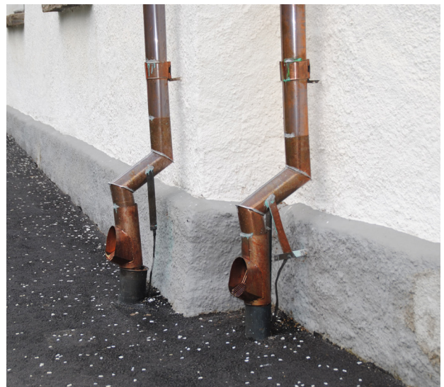
Lövsilarna i plast har bytts ut till nya i kopparfärgad rostfri plåt.
