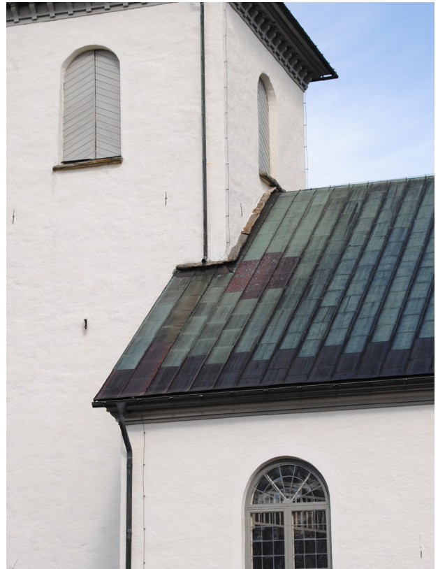
Intill tornet på södra sidan fanns lagningar som gjorts tidigare pga läckage.
