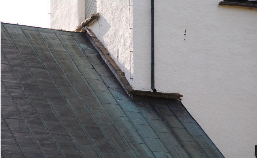
Anslutningen till tornet på norra sidan. Koppertaket går in under en utskjutande stenkil.
