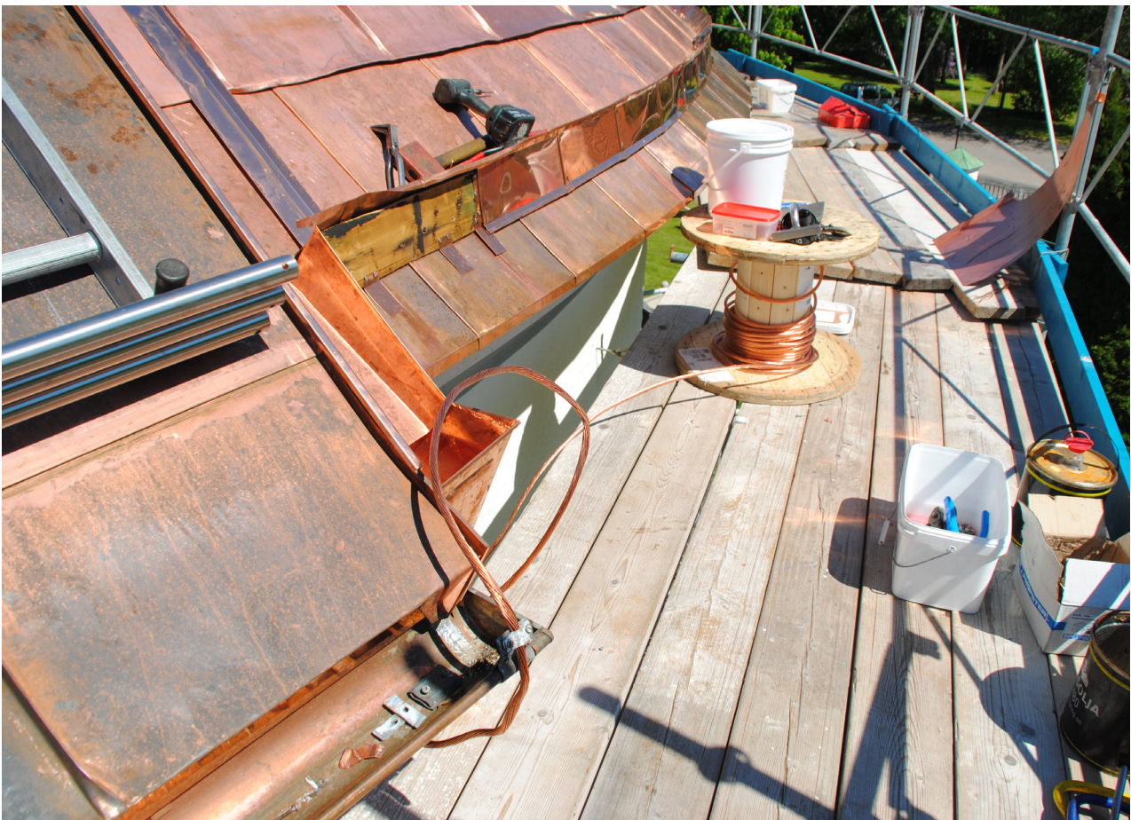
När ändå allting på taken i övrigt blev nytt togs beslut att även alla åskledare och åskledarfästen skulle bytas.
