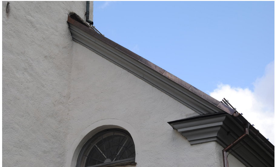
Anslutningen mot tornväggen. Takets ståndskena är uppdragen under den stenkil som finns på tornet.
