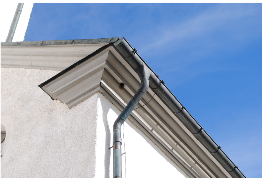
Långhustaket med hänggränna, och böjda stuprören. På varje rännkrok finns en liten dekoration.
