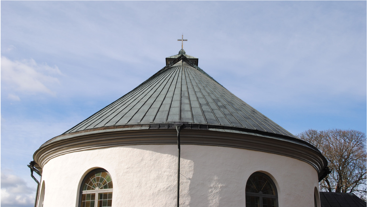
Kortaket före renovering.
